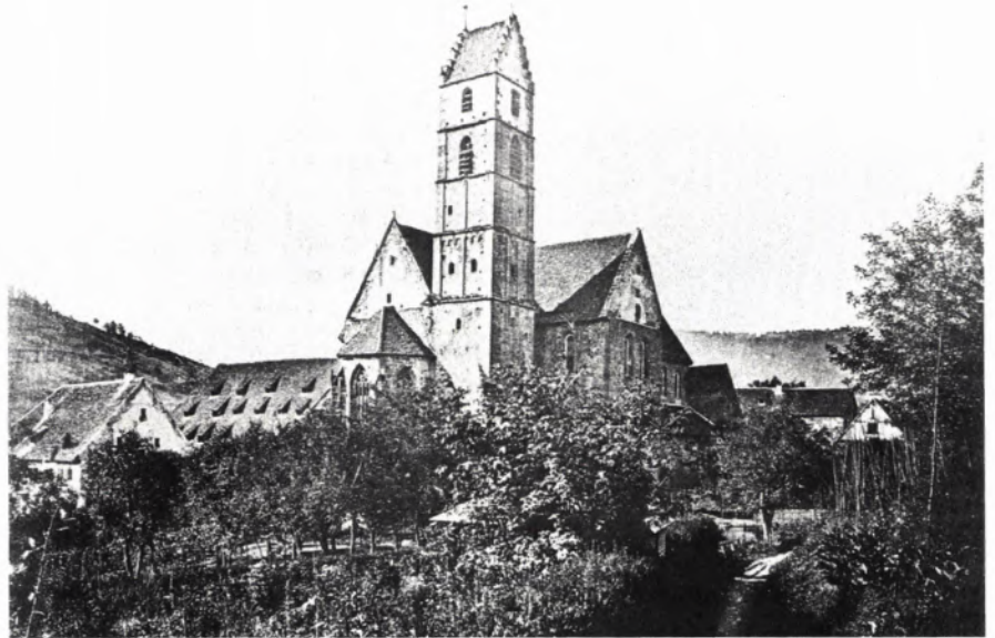
■ 1 Ansicht der Klosteranlage von Osten, Foto von Johann August Lorent, 1866 publiziert.
