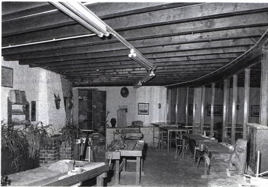
■ 6 Das Innere des Gastraumes heute. Strahlenförmig auseinanderlaufende Sparren gliedern die Decke.
