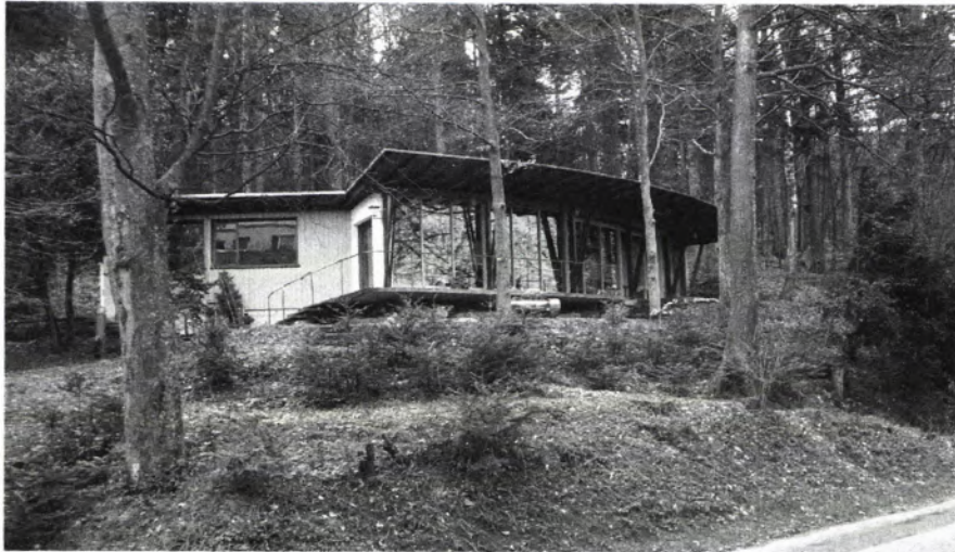
■ 1 Hauptfassade des Sommercafés. Es steht heute unter hochgewachsenen Bäumen.
