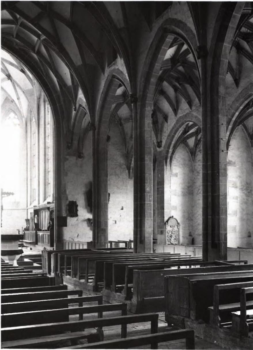
■ 3 Das Innere der Alexanderkirche vor Beginn der Renovierungsarbeiten 1926 mit dem Gestühl aus dem 17./18.Jahrhundert. Photo LDA Stuttgart.
