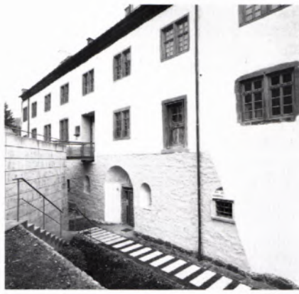
■ 6 An der Ostseite des Konventbaus wurde die schon zur Barockzeit vollzogene Anschüttung 1993 wieder entfernt, um die in feuchte Keller verwandelten Klosterräume im Erdgeschoß wieder zu entfeuchten, belichten und auch wieder sinnvoll nutzen zu können. So hängt die barocke Zugangstüre „heute in der Luft“.
