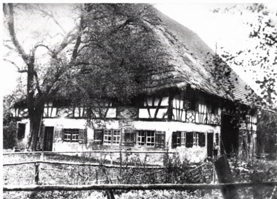
■ 6 Mittishaus (Kr. Biberach), Lindenstraße 3 (Zustand vor 1932). Beispiel eines teilweise veränderten „Altoberschwäbischen Bauernhauses“ aus dem Jahre 1761 mit breitgelagertem Unterbau und mächtigem, strohgedecktem Vollwalmdach.
