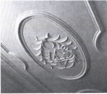
■ 2 Stuckdecke mit Initialen des Bauherrn, Zustand September 1997.
