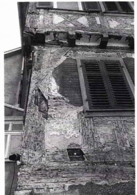
■ 6 Nordgiebel, Detailaufnahme von 1980: Die offenen Blattsassen des spätgotischen Fachwerkes von 1461, das auf Sicht gearbeitet jüngere Umbau-Fachwerk der Barockzeit, die jüngere Übertünchung des Ganzen – noch erkennbar unter dem Stockwerks-Überstand – und der jüngste alles überdeckende Oberputz sind hier abzulesen.
