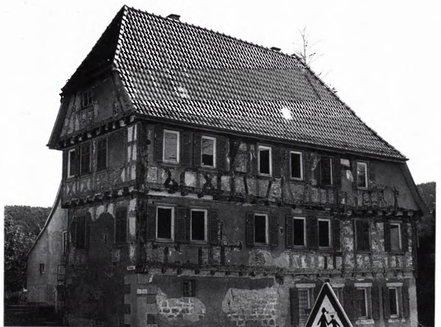
■ 2 Zustand von 1980: Das gleiche Haus als „Schandfleck“, nachdem das neue Pfarrhaus bezogen worden war. Das freigebliebene und freigebliebene Fachwerk zeigt Spuren verschiedener Bauzeiten.
