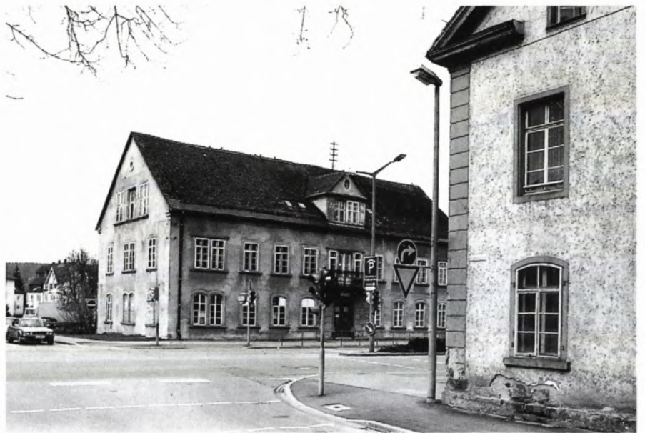
■ 13 Villingen, die ehem. Uhrenschilderfabrik Bertholdstraße 7 (1867; Gewerbeschule 1904–53), im Blick aus der Brigachstraße nach Süden.
