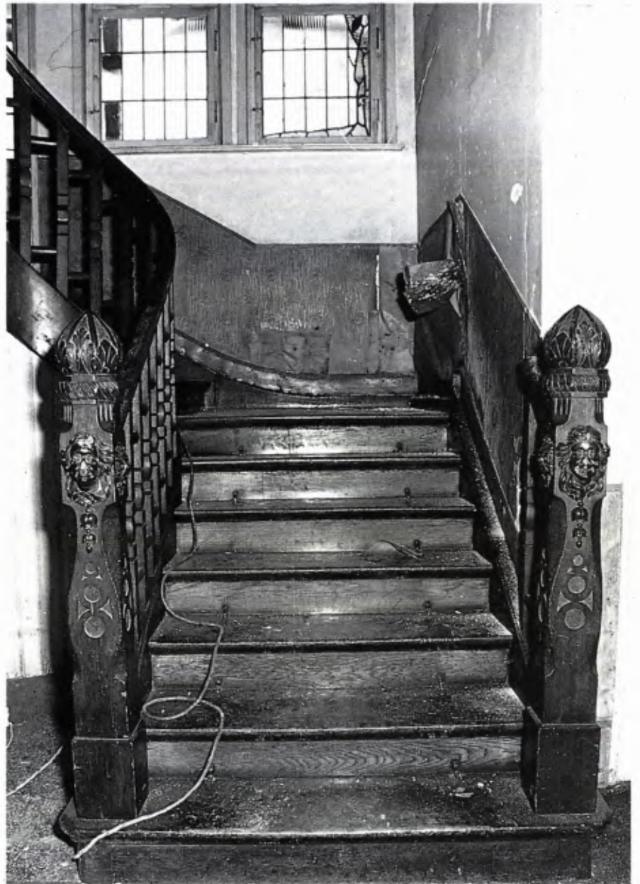
■ 4 Metzinger, Treppe vor der Instandsetzung.
