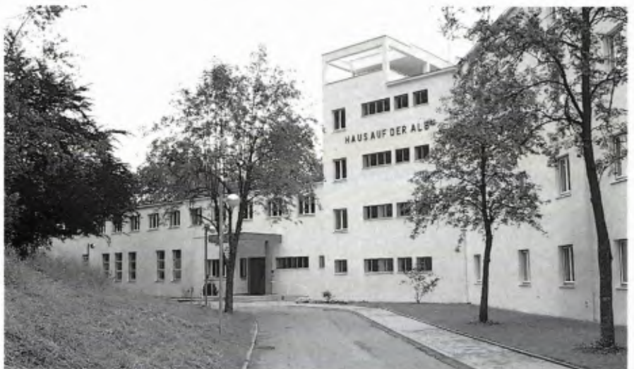
■ 8 Haus auf der Alb, Haupteingang, Nordseite.
