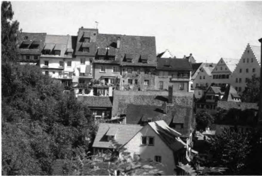
■ 5 Meersburg; Dachlandschaft an der Steigstraße und Winzergasse.
