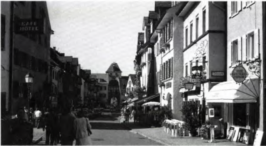
■ 1 Meersburg, Unterstadtstraße; nur wenige dieser Häuser sind Kulturdenkmal.
