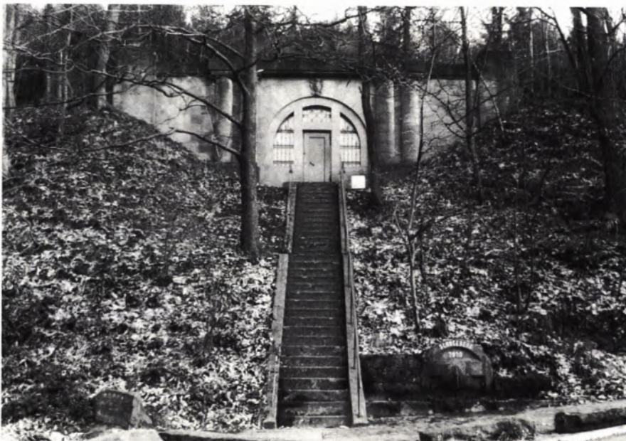
■ 9 Hochbehälter an der Schneebergquelle am Heiligenberg. Erbaut 1910/11.
