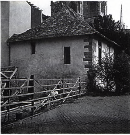
■ 4 Konstanz. Nur noch zwei Geschosse haben sich von dem einst mehrstöckigen repräsentativen Wohnturm unter seinem Barockdach erhalten.
