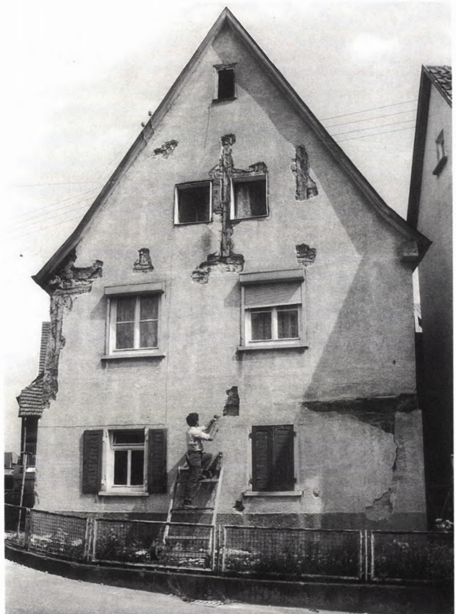
■ 1 Das Haus Schulstraße 8 in Rutesheim, Zustand 1989 bei der Untersuchung des Giebelfachwerks.
