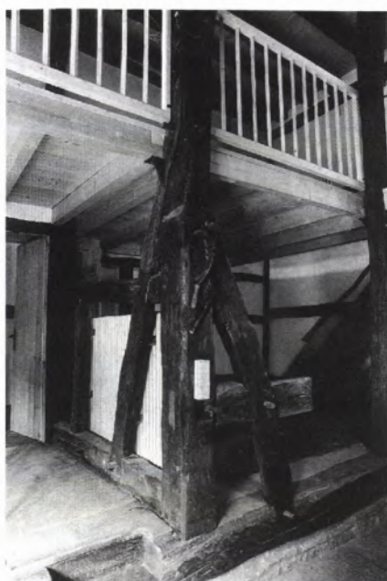
■ 7 Scheunenteil nach dem Ausbau 1992.
