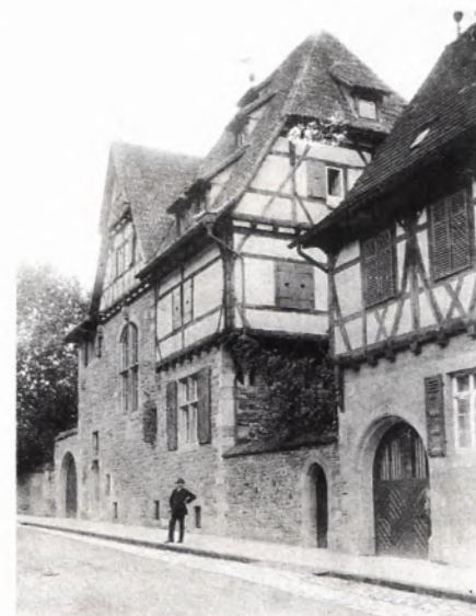
■ 5 Der ebenfalls von Benz für Schimpf entworfene Neubau Mettinger Straße 17 an der Stelle des translozierten – am rechten Bildrand angeschnittenen – Wohnhauses Nr. 19. Vor der Villa wahrscheinlich der Fabrikant Schimpf oder der Architekt Benz posierend. (Ehemals im Besitz des Letztgenannten, heute Stadtarchiv Esslingen, X78/5.)
