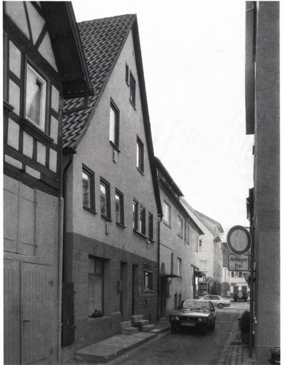
■ 5 Das giebelständige Doppelhaus Mittelgasse 39/41. Die Straßenansicht mit den beiden nebeneinander angeordneten Fluren und den beiden dreiteiligen Fenstergruppen im OG.
