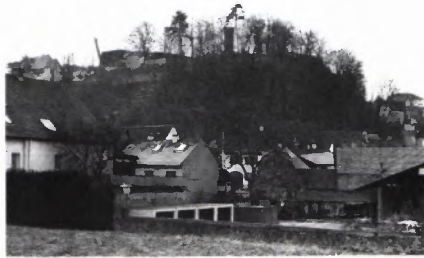
■ 4 Heutiger Zustand des Burggeländes von Nordwesten.
