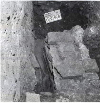
■ 6 Wasserrinne im Badhaus von 1589, die zwischen Stadtmauer (links) und Fundament des Vorgängerbaus (rechts) verlegt wurde.
