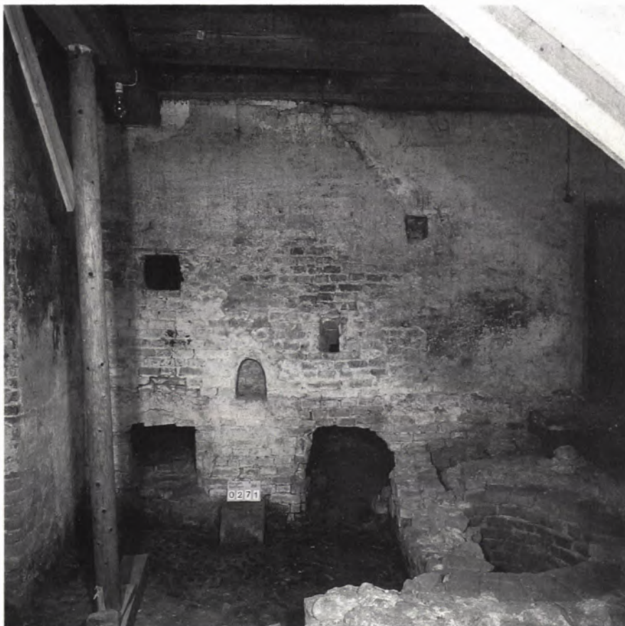
■ 9 Badstube des 17. Jahrhunderts. Fun- damente des Kuppelofens (rechts) und des runden Wasserkessels (links).
