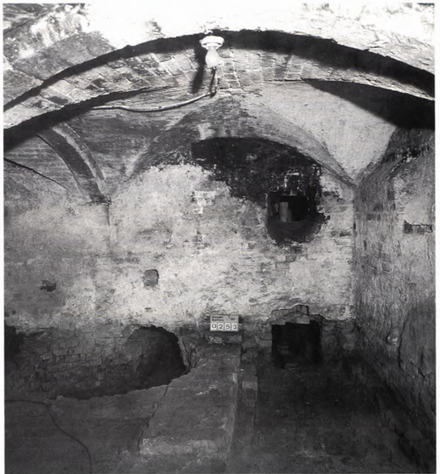
■ 9 Badstube des 17. Jahrhunderts. Fun- damente des Kuppelofens (rechts) und des runden Wasserkessels (links).
