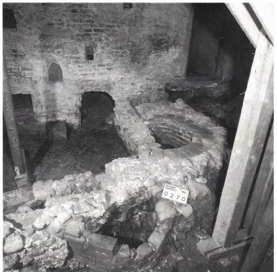
■ 5 Feuerungsraum der Badstube. Im Vordergrund ist der beheizbare Wasserkessel des Badhauses des 15. Jahrhunderts zu erkennen; rechts davon der Kessel des 16. Jahrhunderts, im Hintergrund die Feuerungswand des 17. Jahrhunderts.
