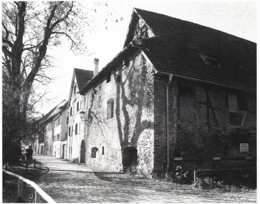
■ 4 Das Badhaus in Wangen mit Resten der Stadtmauer. Die Wackenmauer des 14. Jahrhunderts mit überdachtem Wehrgang bildet den Abschluß der Unterstadt zur Oberen Argen.
