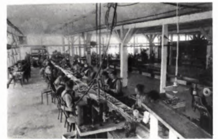
■ 11 Innenansicht Fabrikationsraum in den 1904 und 1908 erstellten Holzskelettbauten. Historische Aufnahme. (Foto: Firmenarchiv der Margarete Steiff GmbH, Giengen/Br.)
