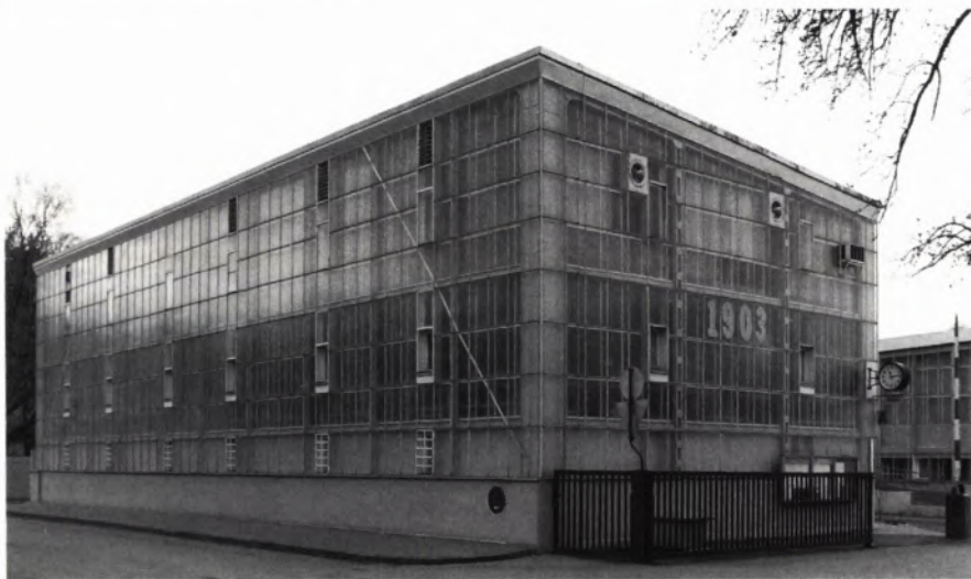
■ 5 Ostbau von 1903, Ansicht von Nord-Ost. Foto 1991.
