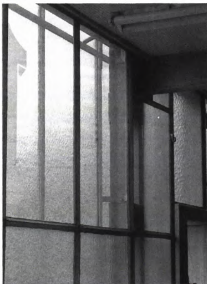
■ 8 Detail der Glasfassade; erkennbar sind die Zweischaligkeit der Außenhaut, die dazwischenliegende Fassadenstütze sowie das Verbindungselement zwischen Stütze und Sprossenwand.
