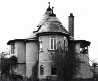
■ 8 Blick auf die kreisförmigen Anbauten, Treppenhaus und Vorräum.
