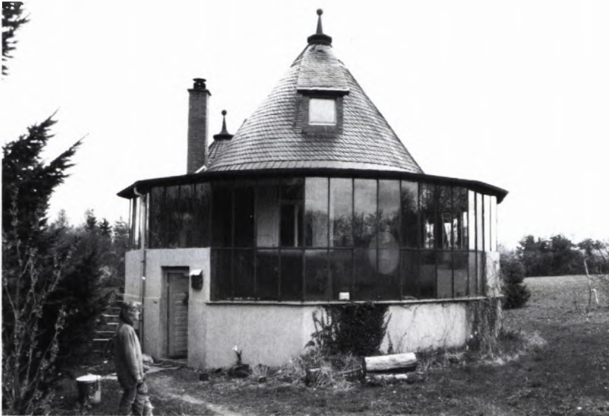
■ 7 Das Rundhaus Gebäude Nr. 5 heute. Die Verglasung ist wiederhergestellt, das Dach wieder in Schiefer gedeckt.
