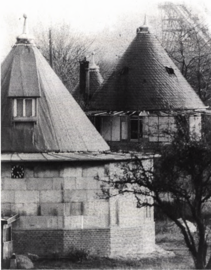
■ 6 Die Rundhaus-Siedlung nach dem 2. Weltkrieg. Die Glaselemente wurden teilweise durch massives Mauerwerk ersetzt, wodurch der Charakter des Glasrundhauses erheblich gestört wurde.
