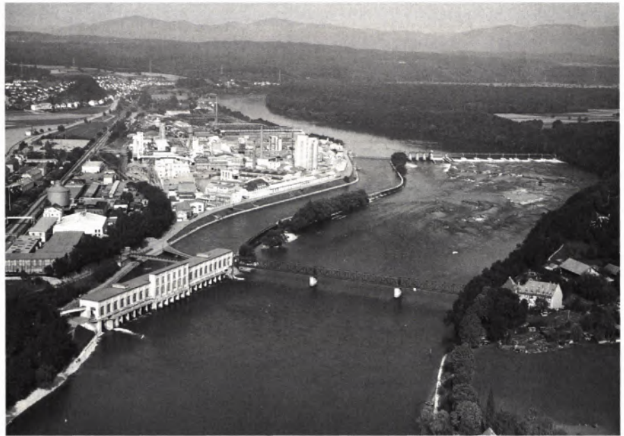
■ 1 Das Kraftwerk Rheinfelden, ältestes, großes Laufwasserkraftwerk Europas und Keimzelle der Industrieregion Hochrhein.
