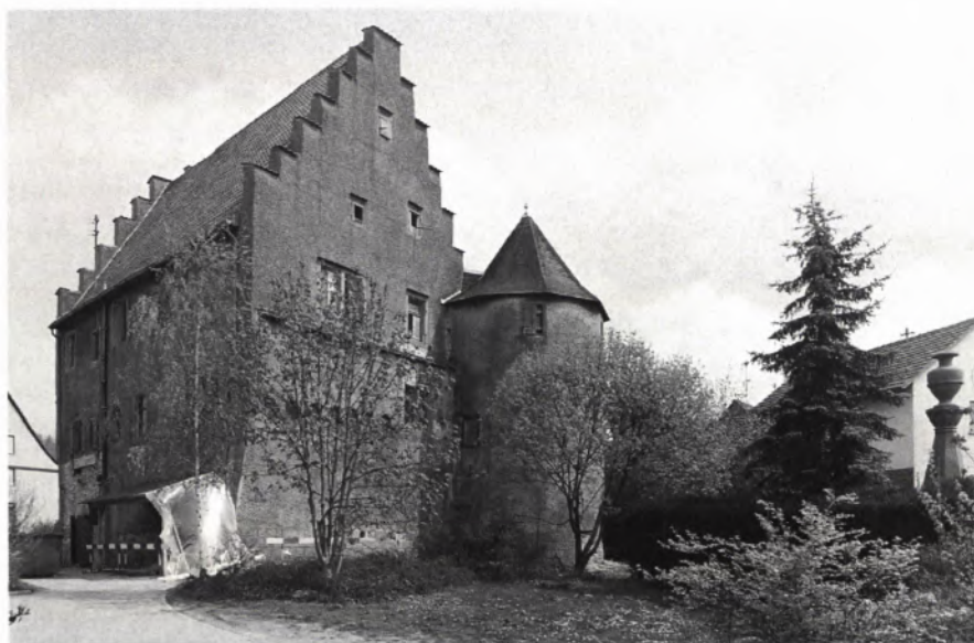
■ 1 Ansicht des Palas vor der Sanierung.
