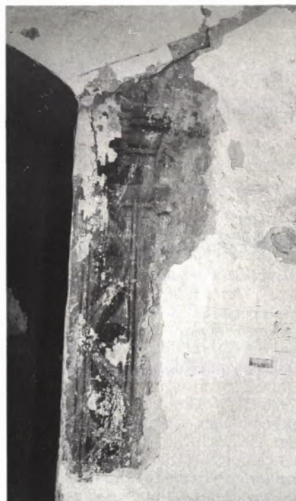
■ 13 Ansicht eines Details der Fensterummalung von Raum 305.
