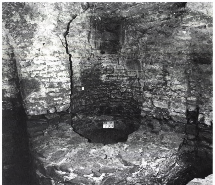
■ 8 Fundamente des Südturmes der 1. Burg mit vermauerter Schießscharte im noch vorhandenen aufgehenden Mauerwerk des heutigen westlichen Kellers, darauf gebaut die Mauern des Palas der 2. Burg.
