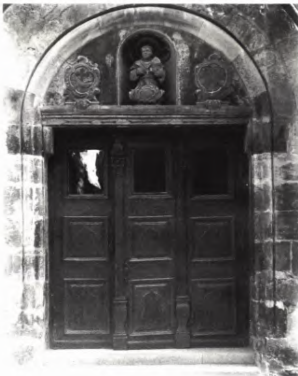
15 und 16 ST. FRANZISKUS: Westportal vor der Restaurierung 1968 und danach.
