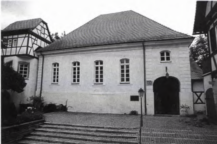
14 FREUDENTAL, EHEM. SYNAGOGE. Nach der Instandsetzung dient das Gebäude als „pädagogisch-kulturelles Zentrum“.
