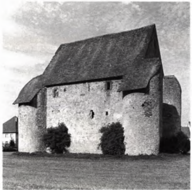
3 DONAUESCHINGEN-PFOHREN, ENTENBURG. Von besonderem denkmalpflegerischen Interesse war die Erhaltung des überlieferten Baubestandes (Zustand 1987).
