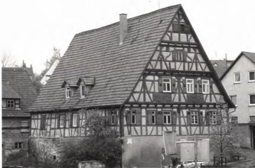
7 WEINSTADT-GROSSHEPPACH, Schäfergäßle 12. Das eingeschossige Fachwerkhaus aus dem frühen 17. Jh. sollte zu einem 6-Familien-Wohnhaus umgebaut werden.
