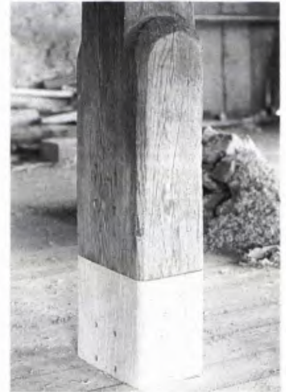
5 und 6 DONAUESCHINGEN-PFOHREN, ENTENBURG. Der Dachstuhl aus der zweiten Hälfte des 16. Jh. konnte trotz erheblicher Wasserschäden an den Dachbalken, Sparrenfüßen und Stuhlschwellen substanzschonend repariert werden. Die Detailaufnahme (rechts) von einem instand gesetzten Stützenfuß belegt die hohe Qualität der Zimmermannsarbeit.
