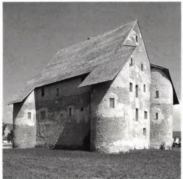
4 DONAUESCHINGEN-PFOHREN, ENTENBURG. Die Gesamtinstandsetzung zeichnet sich durch ein äußerst behutsames und auf den Denkmalbestand rücksichtnehmendes Vorgehen aus.
