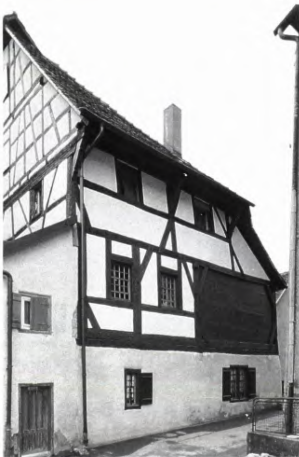
2 ROTTWEIL, LORENZGASSE 21. Nach sorgfältiger Ausbesserung der schadhaften Konstruktionen konnte das ursprüngliche Erscheinungsbild der mittelalterlichen Fassade weitgehend wiederhergestellt werden.
