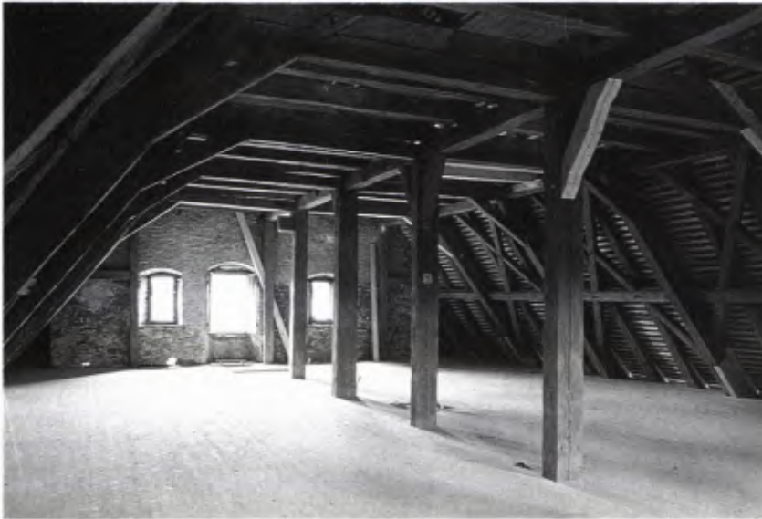
5 und 6 DONAUESCHINGEN-PFOHREN, ENTENBURG. Der Dachstuhl aus der zweiten Hälfte des 16. Jh. konnte trotz erheblicher Wasserschäden an den Dachbalken, Sparrenfüßen und Stuhlschwellen substanzschonend repariert werden. Die Detailaufnahme (rechts) von einem instand gesetzten Stützenfuß belegt die hohe Qualität der Zimmermannsarbeit.
