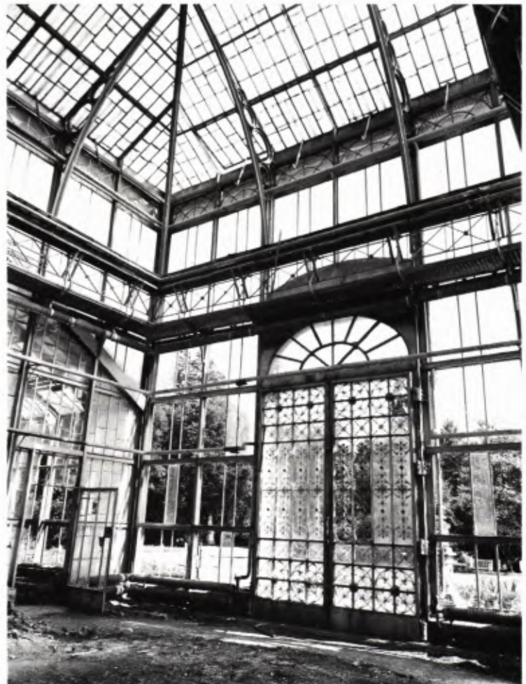
4 TÜBINGEN, Gewächshaus der Universität, vor dem Abbruch 1970.
