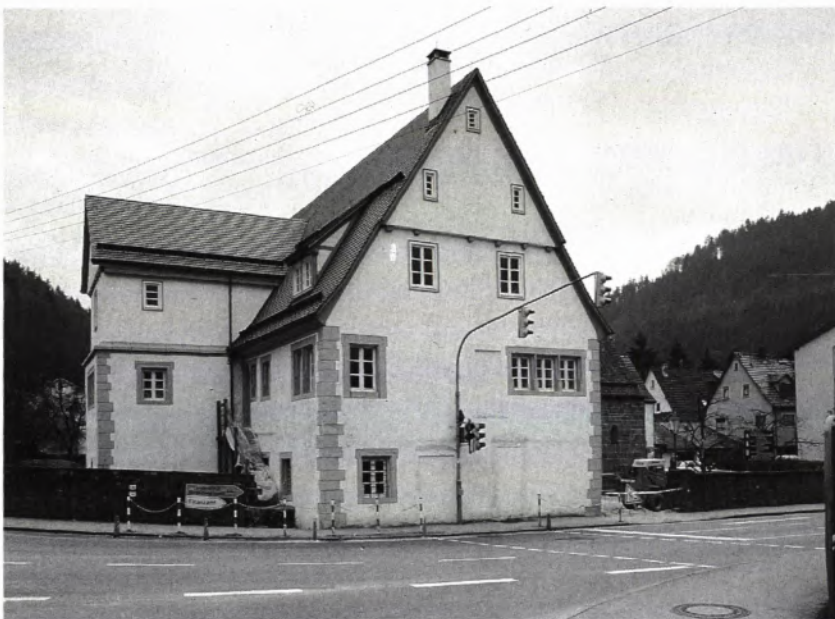
10 NORDFASSADE von Calwer Straße 6, mit Anbau über der ehem. Kapelle, bei Abschluß der Sanierungsarbeiten (April 1991).
