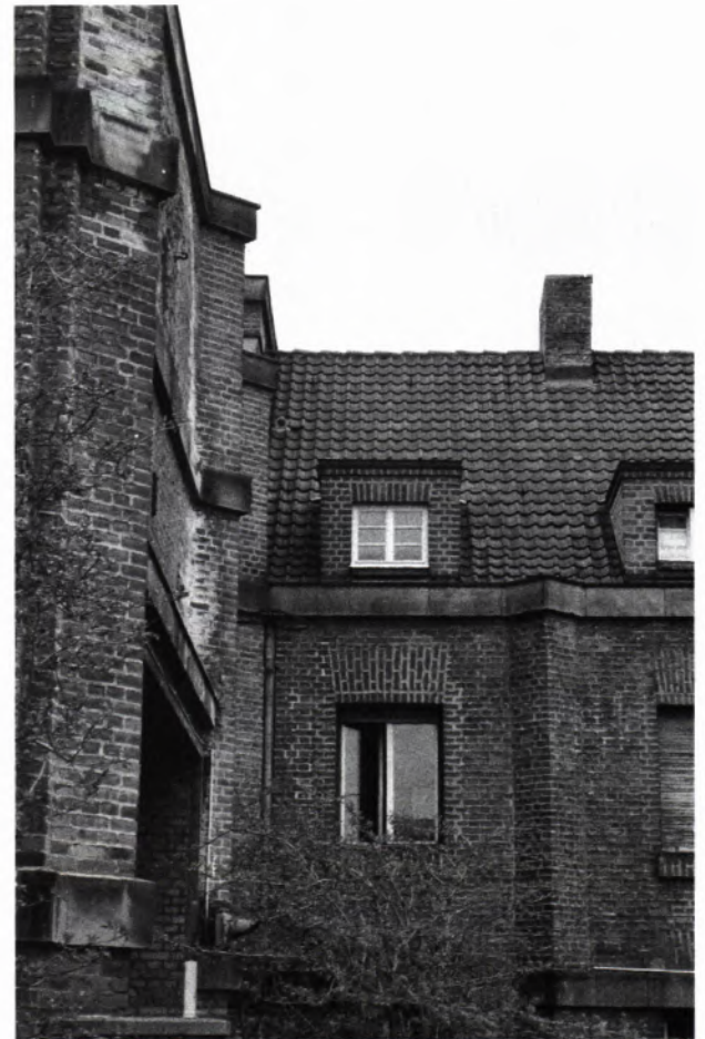
8 DETAIL VON HALLE UND BÜRO- UND WOHNTRAKT des Rhein Stahlwerks in Stuttgart-Feuerbach, Photo März 1991.
