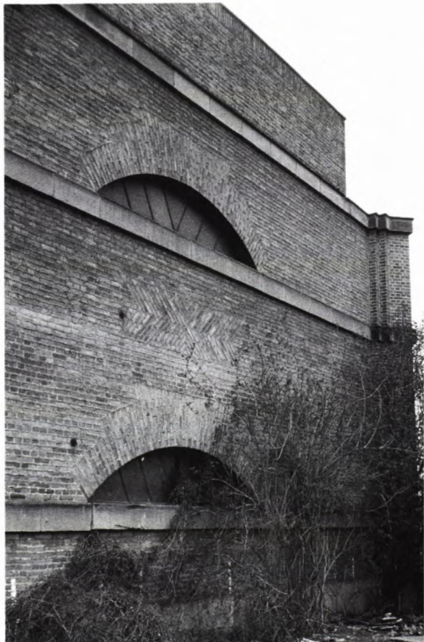
7 DETAIL DER HALLENFASSADE des Rhein Stahlwerks in Stuttgart-Feuerbach, Photo März 1991.
