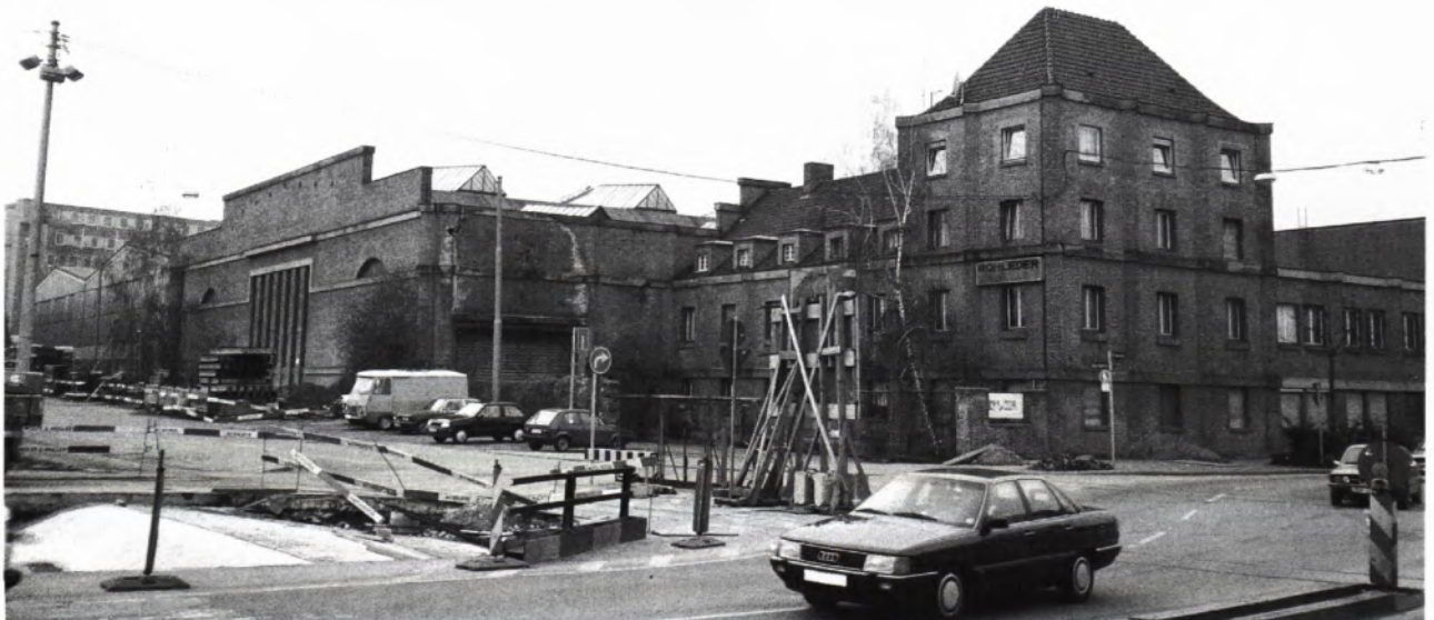
2 GESAMTANSICHT des Rheinstahlwerks in Stuttgart-Feuerbach, Photo März 1991.
