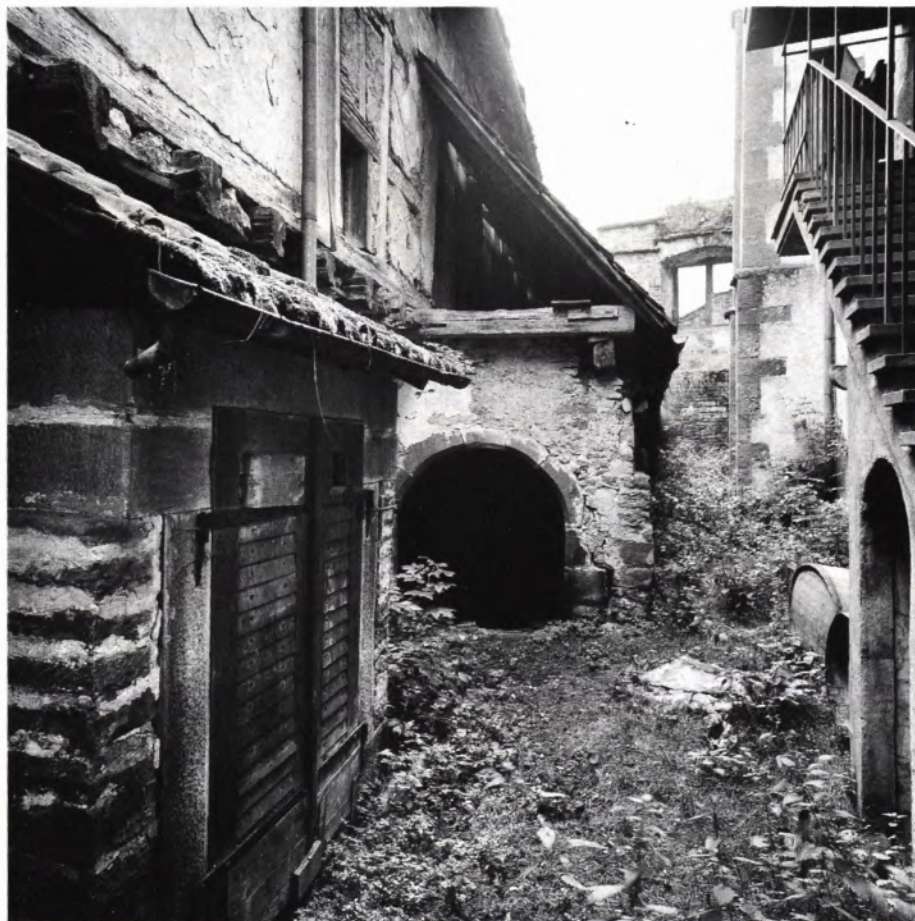
4 FREIRAUM zwischen „Alter Kommende“ und Kirche vor dem Umbau, links überdachte Kellerhalse; Aufnahme 1984.
