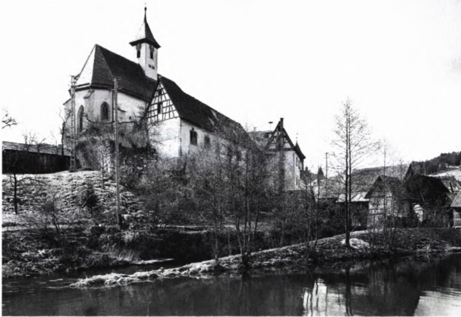
2 DIE JOHANNITERKOMMENDE von Nordosten, vor der Instandsetzung.
