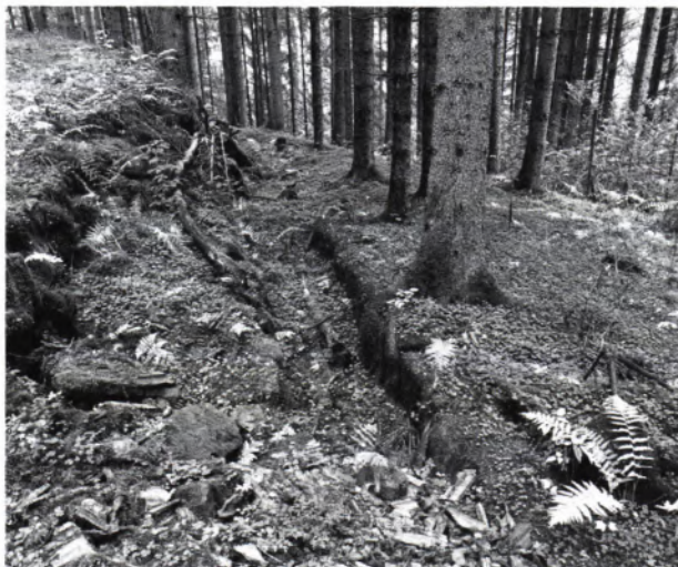
6 AM UNTERLAUF des Wässergrabens, vor dem Zufluß aus den Fuchslöchern, ist die Sandsteinfassung streckenweise noch erhalten.
