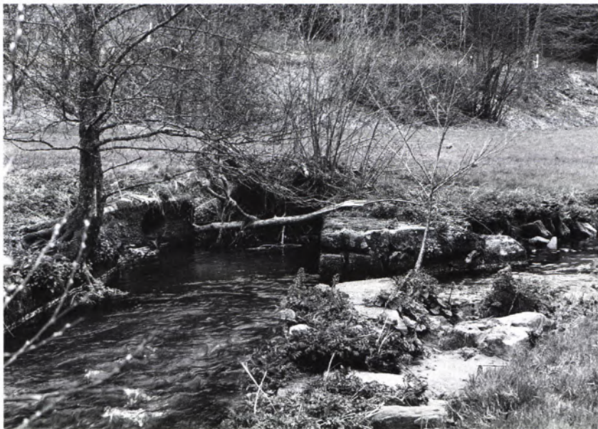
11 ZUGESCHÜTTETER ABZWEIG eines Grabens bei Emberg, im Ansatz noch vorhanden. Die Teinach konnte hier gestaut werden, wie die Führungsnuten in den Sandsteinblöcken zeigen. Der Graben verlief im Bildhintergrund am Fuß des Rains.
