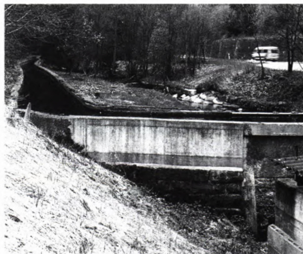
12 UNTERLAUF des Mühlgrabens bei Altbulach. Am rechten Bildrand ist der Ansatz des Betonaquädukts über die Teinach sichtbar.
