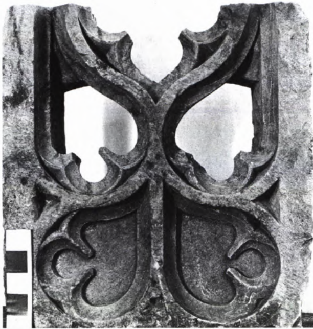
2 EINE EINZELNE MASSWERKPLATTE mit Fischblasen-Ornamentik. Die Verdickung für die vermutete Stand-Platte bedingte das Blendmaßwerk.
