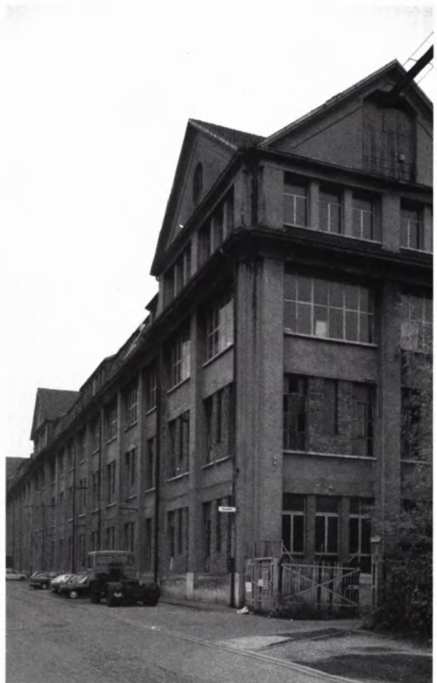
5 HALLENBAU A, Südwestecke. Im 2. Obergeschoß sind die ursprünglichen großen Fensteröffnungen erhalten geblieben.
