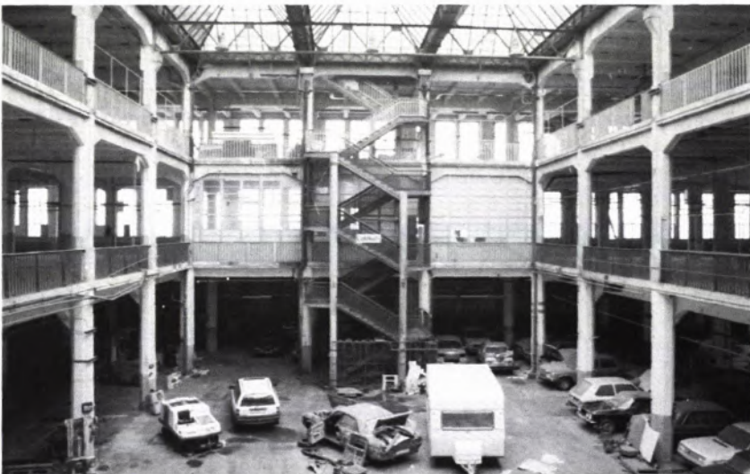
3 EINER DER ZEHN „LICHTHÖFE“ des Hallenbaus A.
