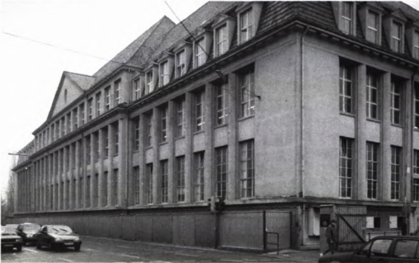
2 STRASSENFRONT DES WOHLFAHRTSGEBÄUDES. Ein Zaun vor dem Sockelgeschoß beeinträchtigt das Erscheinungsbild.
