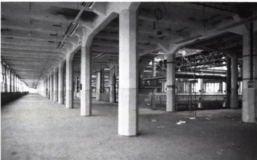
4 HALLENBAU A, 1. Obergeschoß. Blick entlang der Westfront.
