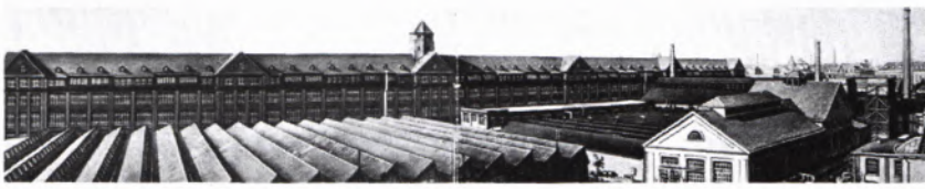
1 DEUTSCHE WAFFEN- UND MUNITIONSFABRIKEN in Karlsruhe, erbaut 1915-18, Architekt Philipp Jakob Manz. Blick auf den Hallenbau A vom Wohlfahrtsgebäude aus. Foto 1939.
