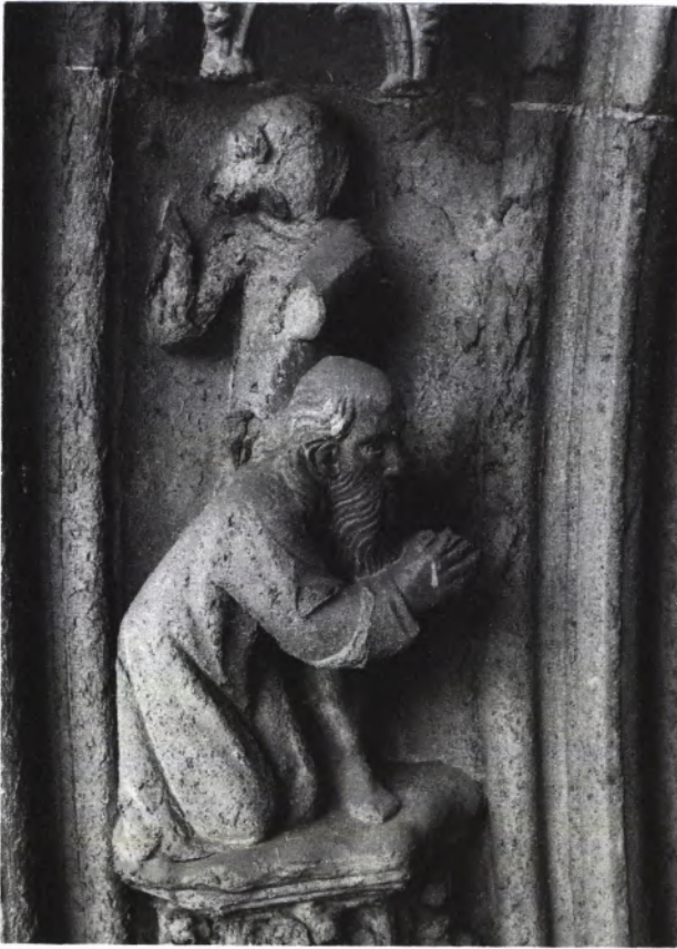
5 „MÄRTYRER-SZENE“, Detail von einer Archivolte des nördlichen Chorportals, Zustand 1985: fortgeschrittene Zerstörung der originalen Figuren-Oberfläche.
