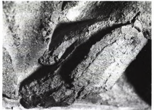
5 „MÄRTYRER-SZENE“, Detail von einer Archivolte des nördlichen Chorportals, Zustand 1985: fortgeschrittene Zerstörung der originalen Figuren-Oberfläche.
