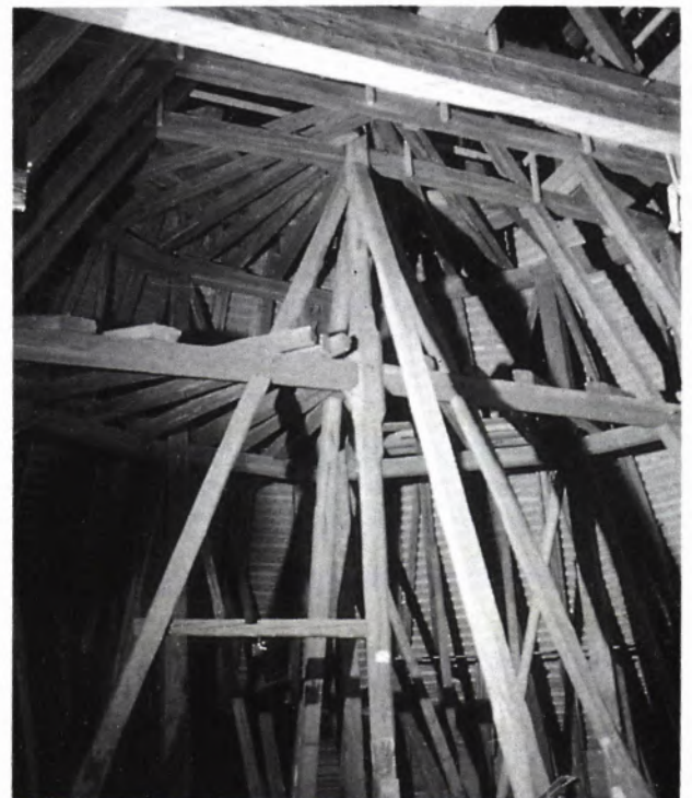
4 HEILIG-KREUZ-MÜNSTER, Blick auf den abgestrebten Kaiserstiel, von dessen Firstspitze der Chorwalm abfällt.
