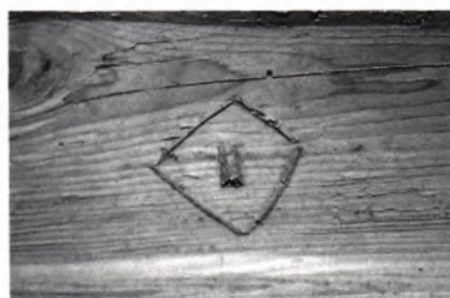
7 MARKIERUNGSFOLGE im Chordach mit Symbolzeichen (Ausschnitt).
