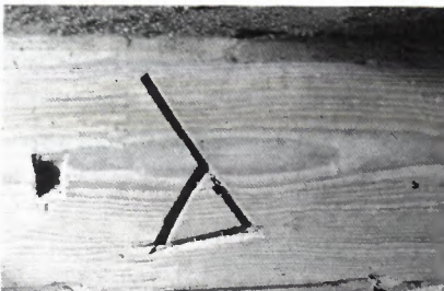
10 MARKIERUNGSFOLGE im Langhausdach mit Symbolzeichen und Zusatzkerbe (Ausschnitt).
