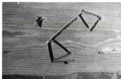
10 MARKIERUNGSFOLGE im Langhausdach mit Symbolzeichen und Zusatzkerbe (Ausschnitt).
