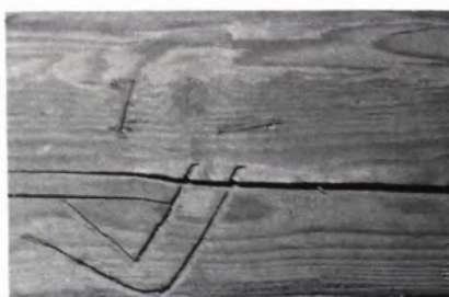
7 MARKIERUNGSFOLGE im Chordach mit Symbolzeichen (Ausschnitt).
