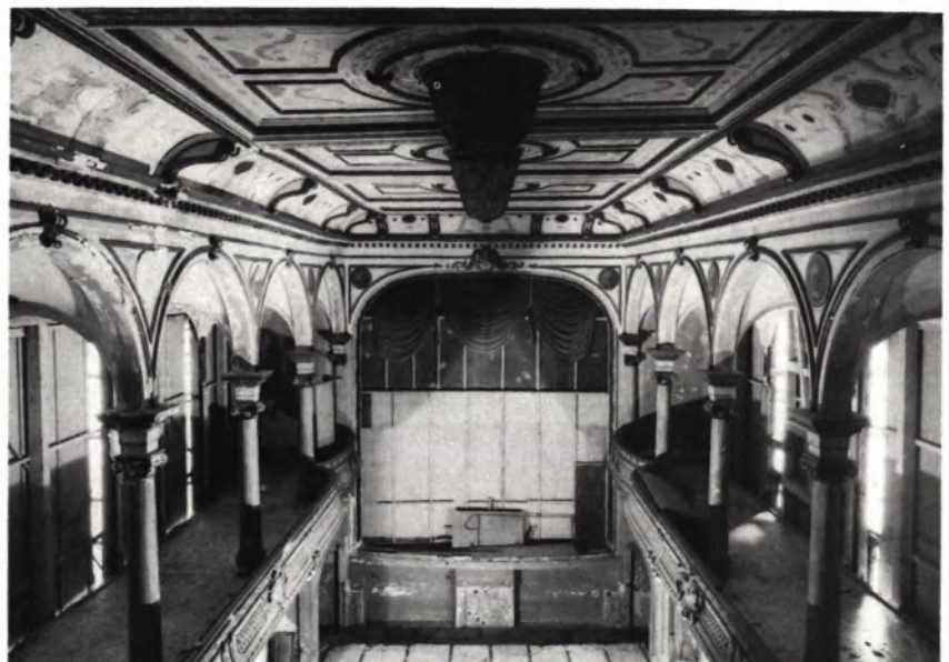
16 DER ZUSCHAUERRAUM zur provisorisch geschlossenen Bühne hin. Seitlich sind die behelfsmäßigen Eiernitaußenwände zu erkennen.
