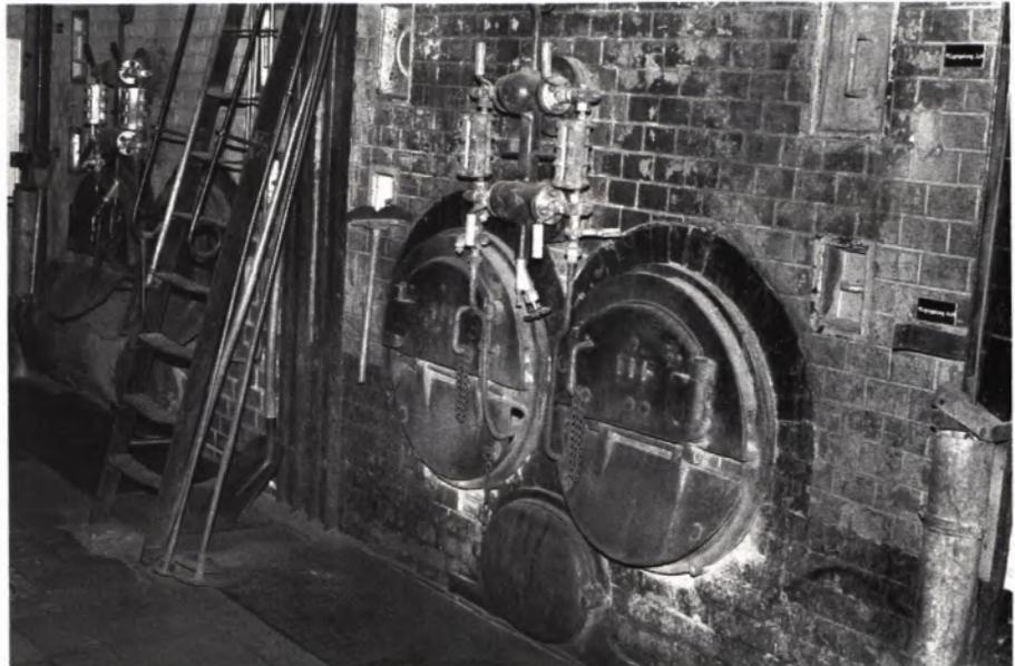
3 BLICK DURCH DIE FEUERTÜR auf Planrost und Flammrohr. Deutlich ist das Profil des sog. Foxwellrohres zu erkennen.
