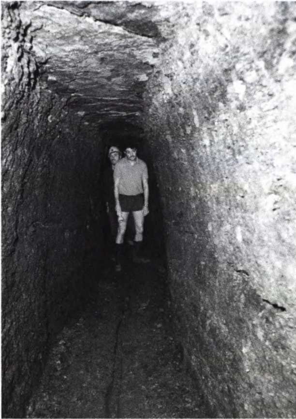
7 DIE SPURLATTEN lagen rechts und links der Leitrine. In der Rinne verlief der Spurnagel des Förderkarrens und hielt ihn in der Stollenmitte.
