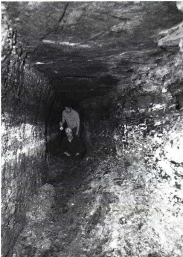
8 AN DEN STOLLENWÄNDEN sind Gips und Jarosit ausgeblüht. Die Tonschichten der rechten Wand sind unter Einwirkung von Schwefelsäure mürbe geworden und eingebrochen.
