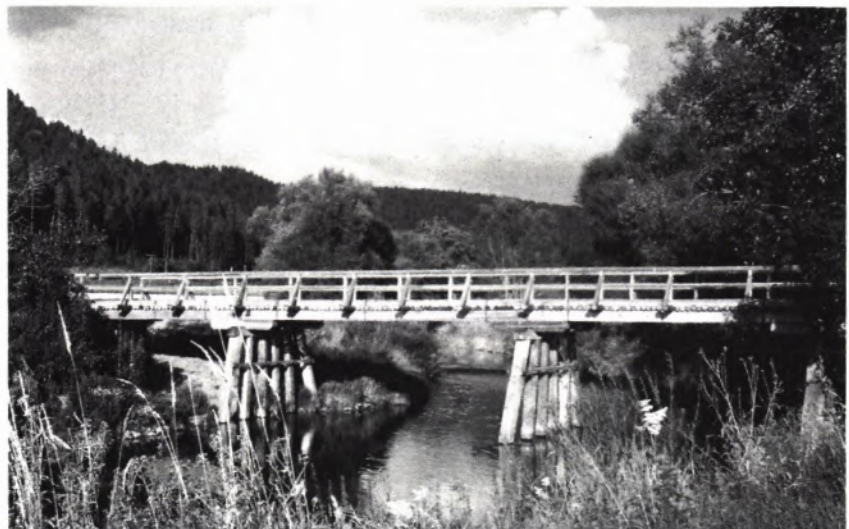
2 DIE PFAHLJOCHBRÜCKE nach ihrer Instandsetzung im Jahr 1988.
