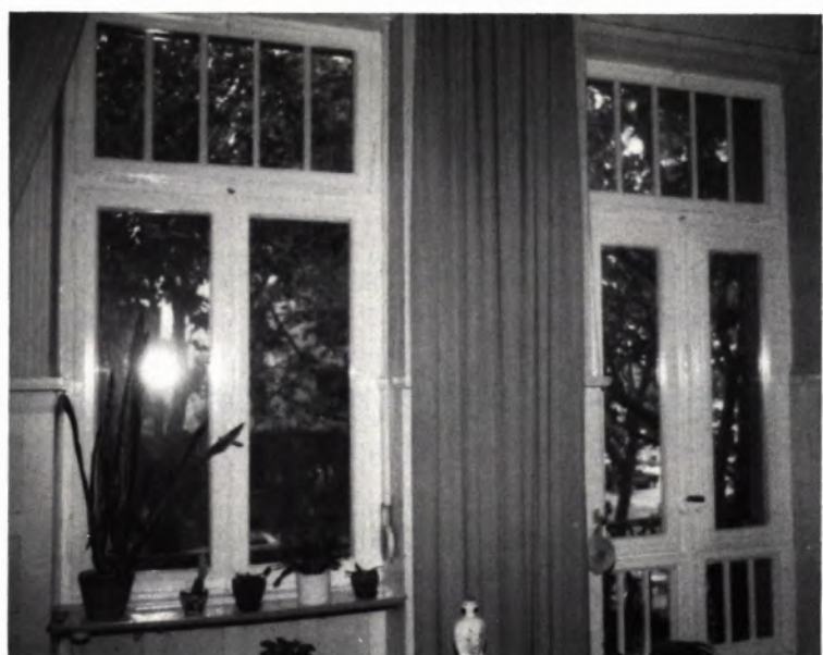
4 u. 5 OTTO-BECK-STRASSE 10. Links Originalfenster instand gesetzt und umgebaut 1989. Rechts Originalfenster, Innenseite, instand gesetzt und umgerüstet (Isolierverglasung bzw. Verbundverglasung).
