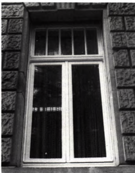
4 u. 5 OTTO-BECK-STRASSE 10. Links Originalfenster instand gesetzt und umgebaut 1989. Rechts Originalfenster, Innenseite, instand gesetzt und umgerüstet (Isolierverglasung bzw. Verbundverglasung).
