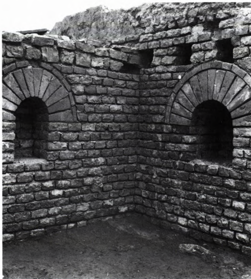
10 KELLER von Gebäude 19 mit hervorragend erhaltenen Mauern und Abstellnischen. Die Balkenlöcher für die Holzdecke sind gut sichtbar.
