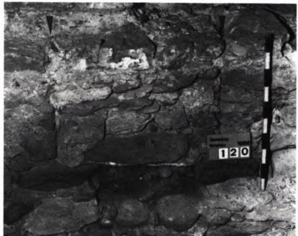
4 ZUGESetzte TÜR im Fundament des Waaghause, östlicher Eingang zum Spital.
