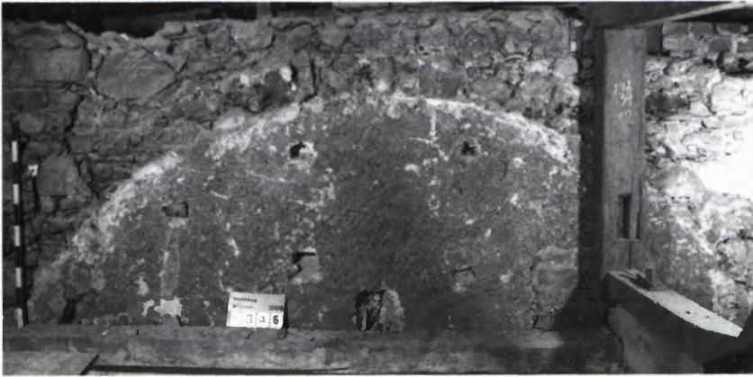
5 ABDRUCK eines Gewölbes im aufgehenden Mauerwerk der Westwand des Waaghhauses.
