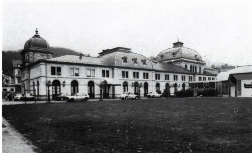
6 ANSICHT DER RÜCKWÄRTIGEN FRONT des Bahnhofs zu den ehemaligen Gleisanlagen, 1988. Blick nach Nordosten. Links das Obergeschoß der fürstlichen Eingangshalle, rechts von der Schalterhallenkuppel der Ansatz des „Interimpavillons“.
