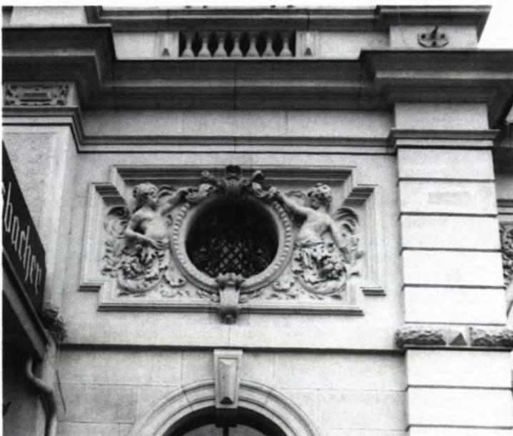
12 SCHALTERHALLE des Bahnhofs, Fassadendetail im Erdgeschoß, 1987. Einfassung eines Rundfensters rechts vom Haupteportal; Blick nach Süden.
