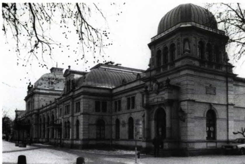
5 DIE HAUPTFASSADE mit westlich anschließendem fürstlichem Bahnhofsteil, 1987. Blick nach Südost.
