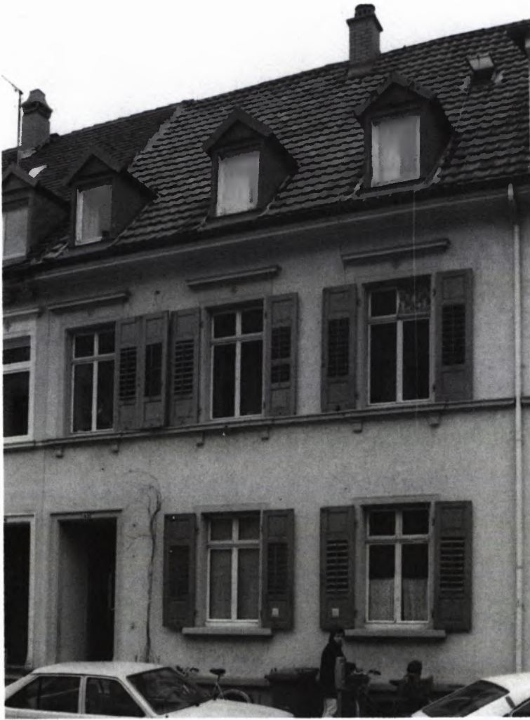
6-8 TYPISCHE HÄUSER der Klarastraße (be- baut ca. 1880-1885) und der Guntramstraße (be- baut ca. 1895-1900) im Vergleich mit dem Haus Eschholzstraße 37 (erbaut 1903/04).
