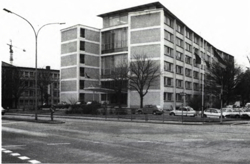
5 FREIBURG, Friedrichstraße 39, 1954 vom Sonderbauamt Freiburg errichtetes Hauptquartier der Französischen Armee. Der Y-förmige Grundriß mit zurückversetztem Eingang, die Stahlbetonskelett-Konstruktion und das völlig verglaste Penthouse charakterisieren dieses eigenwillige Gebäude (Foto 1983).
