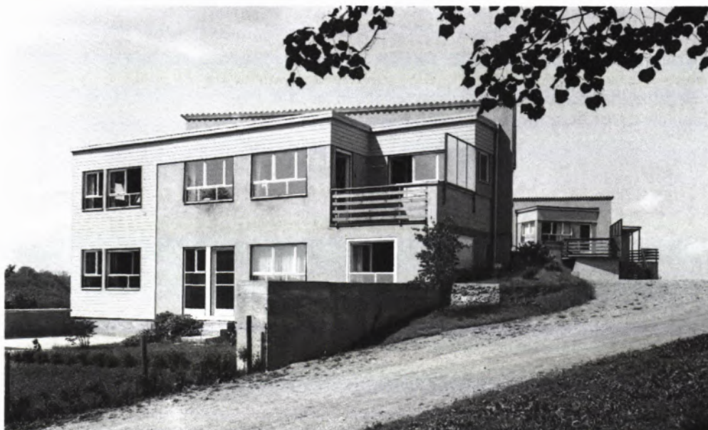
1 BIBERACH, Haus Mettenberger Weg 17, 1950 zusammen mit dem Nachbarhaus Mettenberger Weg 15 von Hugo Häring errichtet, schon 1970 (2 Jahre vor dem Denkmalschutzgesetz!) als wichtige Werke dieses seit den 20er Jahren hochbedeutenden Architekten in das Denkmälerverzeichnis eingetragen (Foto 1970).
