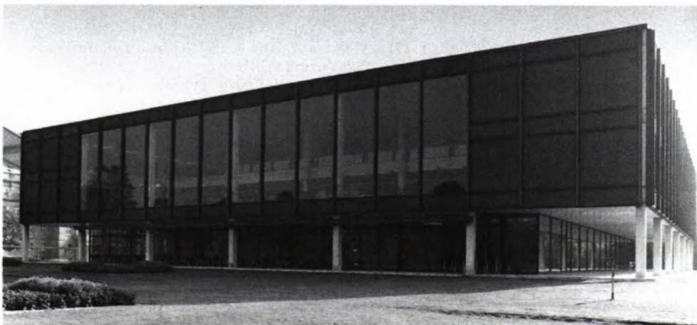
10 STUTTGART, Landtagsgebäude, 1959–61 von der Staatlichen Finanzbaubehörde Baden-Württemberg (Architekten Erwin Heinle und Horst Linde nach einem überarbeiteten Entwurf von Kurt Viertel). Die Stahlbetonskelett- Konstruktion ist in Bauweise, in innerer und äußerer Gestaltung ganz dem Neuen Bauen verpflichtet (Foto 1986).
