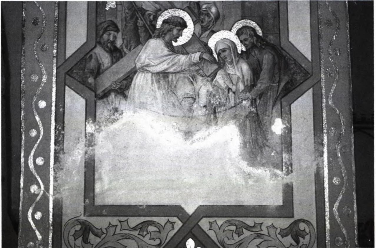
1 AUFSTEIGENDE SALZE haben die Malschicht in Sockelhöhe bereits zerstört...
