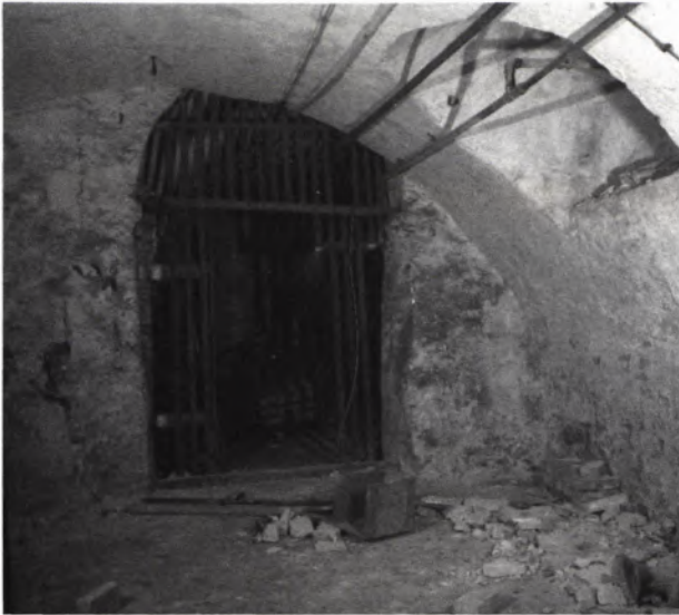
20 SÜDLICHE KELLERWAND des Steinhauses mit dem ehemals von der Hauptstraße aus zugänglichen romanischen Eingang, der von dem später eingezogenen Gewölbe überschritten wird.
