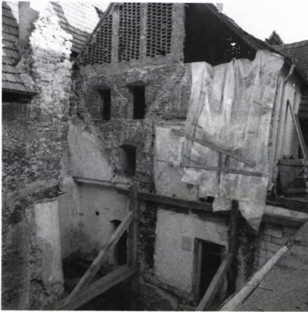
4 NORDWAND des Steinhauses nach Abbruch des Gebäudes Nr. 6.
