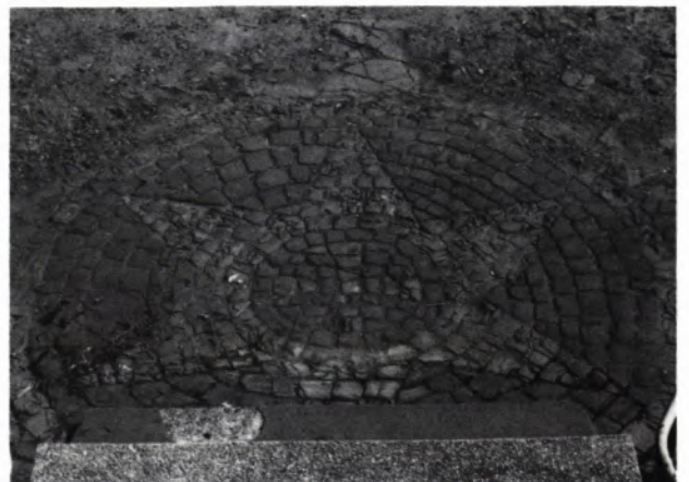
7 HELMSTADT-BARGEN, Rabanstr. 16, 18./19. Jahrhundert. Beispiel einer anspruchsvollen Treppenvorplatzgestaltung. Mit Kopfsteinpflaster belegte Kreisfläche, der ein andersfarbiges Sternmotiv einbeschrieben ist. Die große Hofffläche ist unbefestigt. (Treppenanlage später erneuert.)
