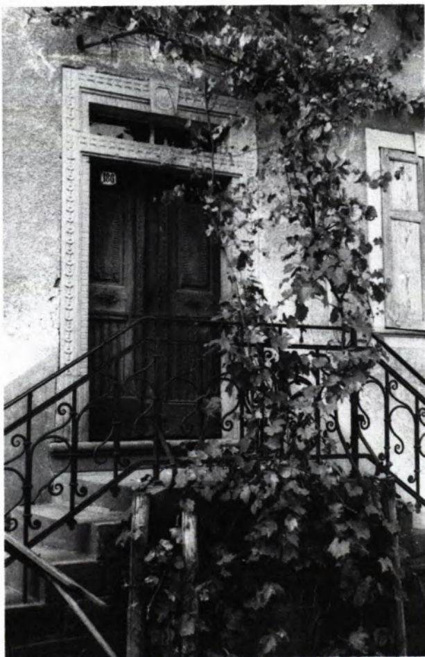
12 u. 13 · WAIBSTADT, 1800, Zustand 1971/1985. Klassizistische zweiflügelige Türe. Kämpfer und Gewände mit dem Motiv aufgerichteter Scheiben verziert. Der nichtssagenden einflügeligen Holzglastüre mußte der Kämpfer weichen. Anstelle des Weinstocks „schmückt“ heute ein Waschbetonpflanzkübel den Eingang.
