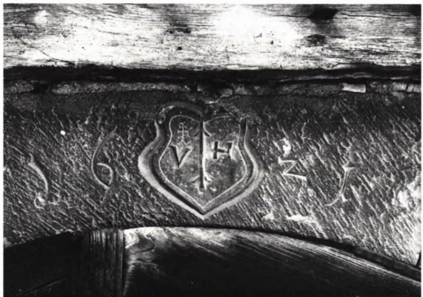
32 WAIBSTADT, Lammstr. 9 , 1621. Der datierte Kellereingangsbogen hat ein Kartuschenfeld mit Initialen V.-H., die durch Hauszeichen in Pfeilform getrennt sind. Über dem linken Buchstaben befinden sich Steinmetzzeichen.
