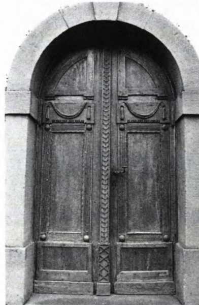
23 ZUZENHAUSEN, Brunnengasse 12, 1790. Zweiflügelige Türe der Übergangszeit mit Pilaster als Anschlagleiste und integriertem Oberlicht. Die geschweiften Füllungen im Stile des Barock sind kombiniert mit für die Zeit des Zopf-stiles und des Rokoko typischen Motiven.
