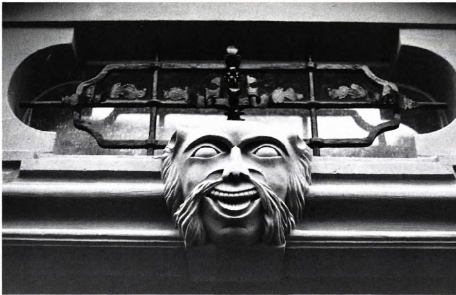
33 SINSHEIM-HILSBACH, ehem. Leiningensches Amtshaus, 1732. Grotteske Maske (Neidkopf) am Oberlichtkämpfer (Kopie).
