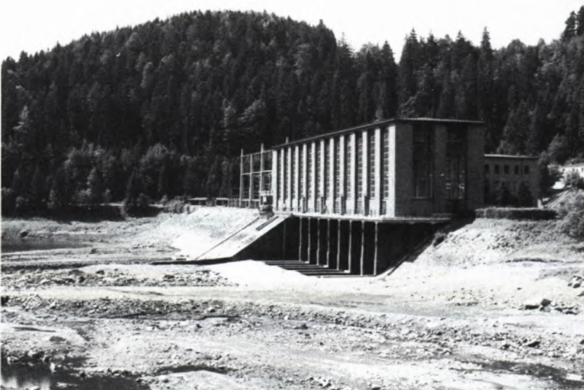
13 KRAFTWERK HÄUSERN, 1933 errichtet. Es ist das älteste der drei Kraftwerke der Werkgruppe Schluchsee (Foto 1986).
