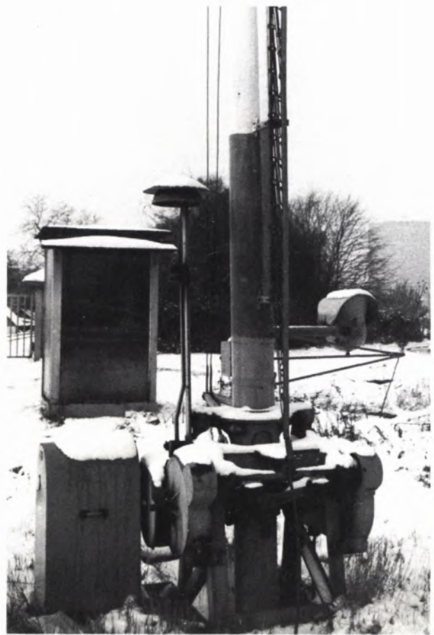
6 LÄUTEWERK einer Schrankenanlage in Stuttgart-Wangen (Foto 1986).
