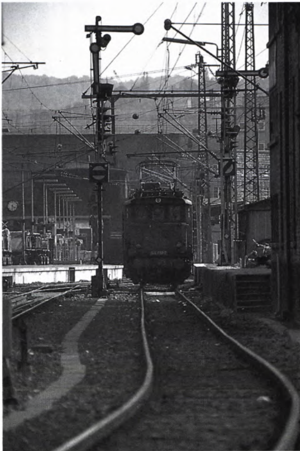
4 STUTTGART, Hauptbahnhof. Die alte Einfahrt nach Gleis 1 mit Flügelsignalen und Sperrsignalen (Foto 1977).
