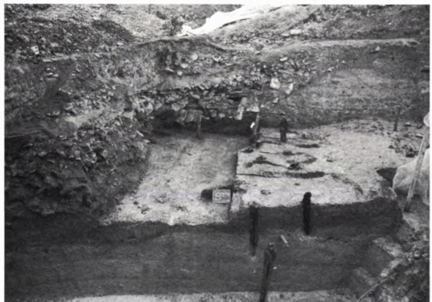
4 SCHROZBERG, Kr. Schwäb. Hall, ehem. Burg. Eingerammte Buchenpfähle zur Festigung des Fußes des aufgeschütteten Burghügels.
