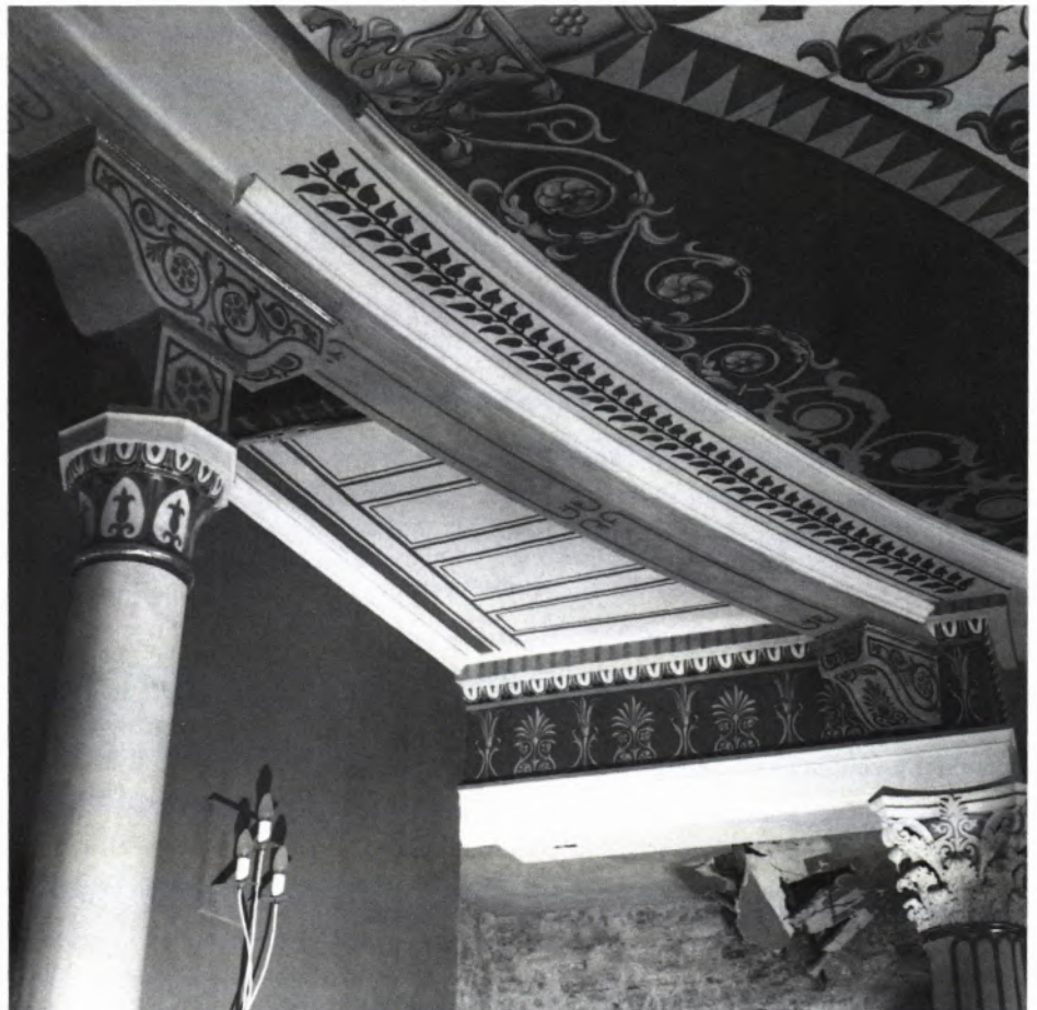
28 ZUSTAND 1986 mit den ersten Arbeitsproben an der Decke und der Deckenuntersicht im 2. Rang (Ausschnitt).
