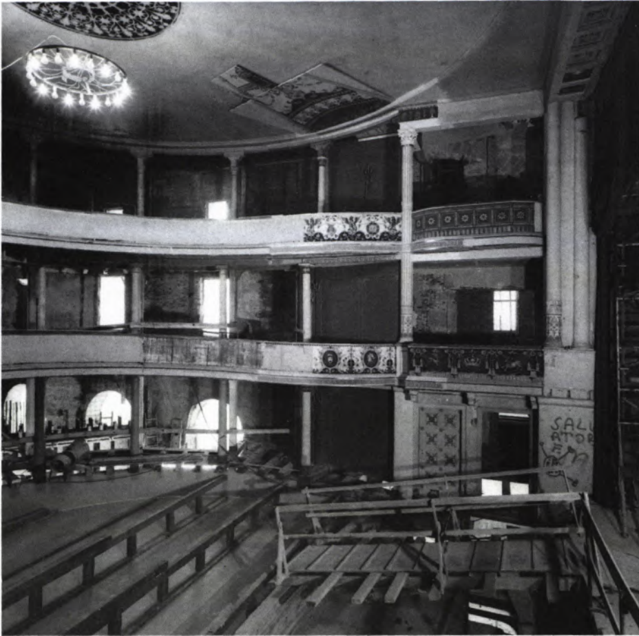
27 ZUSTAND 1986 mit den ersten Arbeitsproben an der Decke und den Brüstungen im Zuschauerraum.
