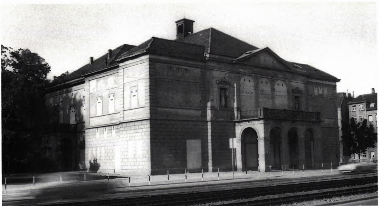
12 DAS THEATER mit vermauerten Fenstern und Türen, Aufnahme um 1970.
