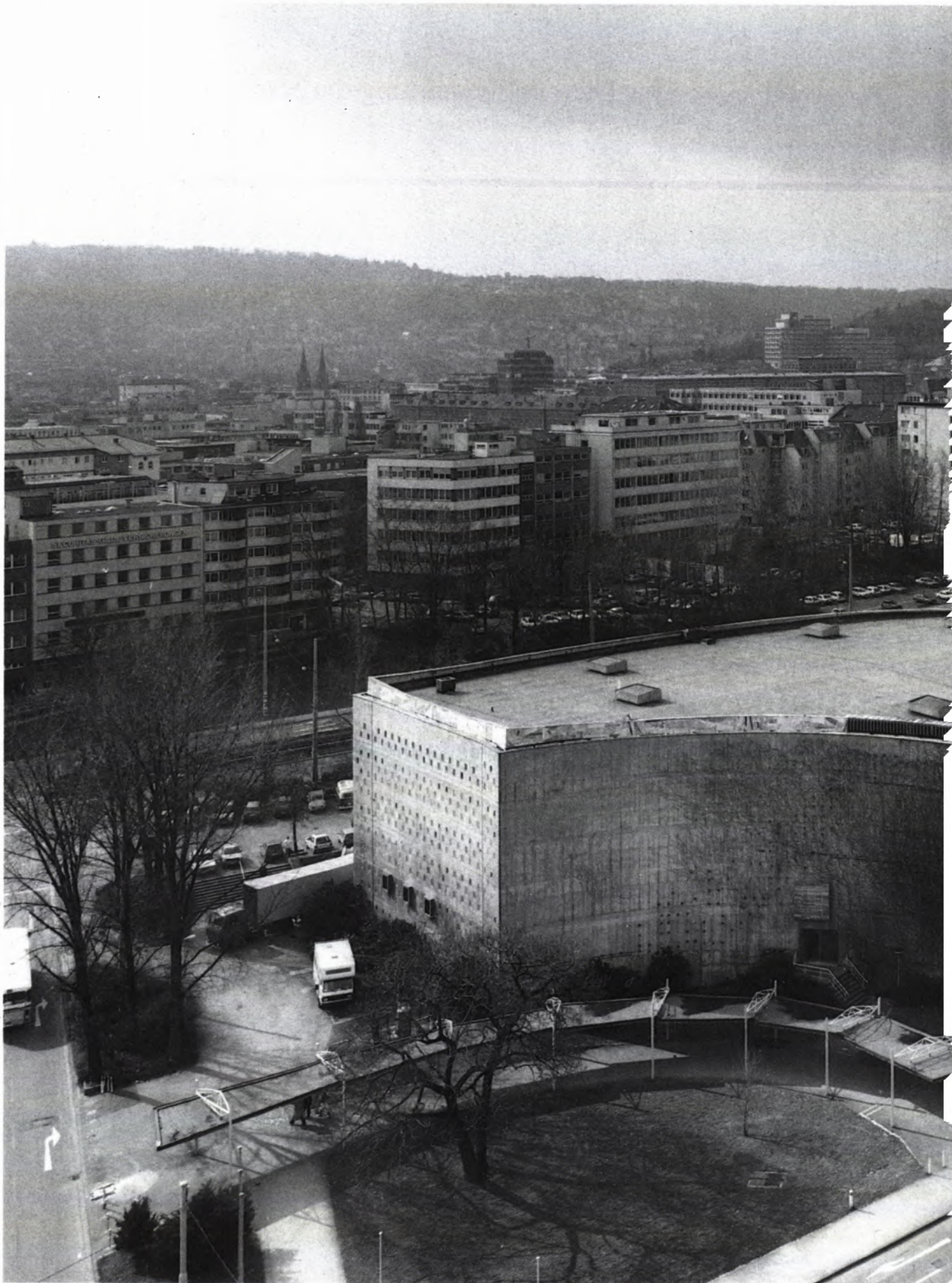
1 GESAMTANSICHT DER LIEDERHALLE. Im Zentrum der Sichtbetonbau des Beethovensaals mit seinen geschwungenen Außenmauern eckige Baukörper des Silchersaales.
