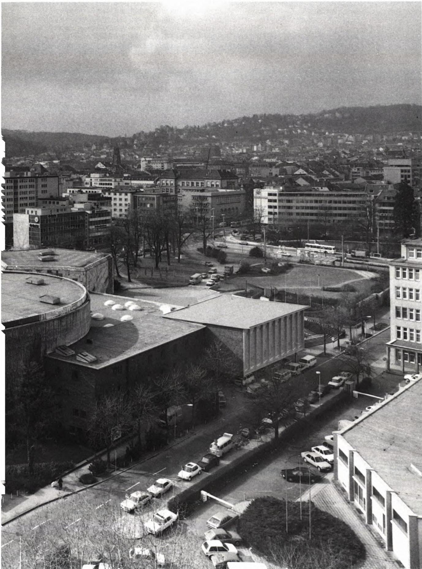
avor die frei stehende, an Stahlträgern aufgehängte Betonüberdachung; im Hintergrund der polygonale Mozartsaal; rechts der annähernd recht-
