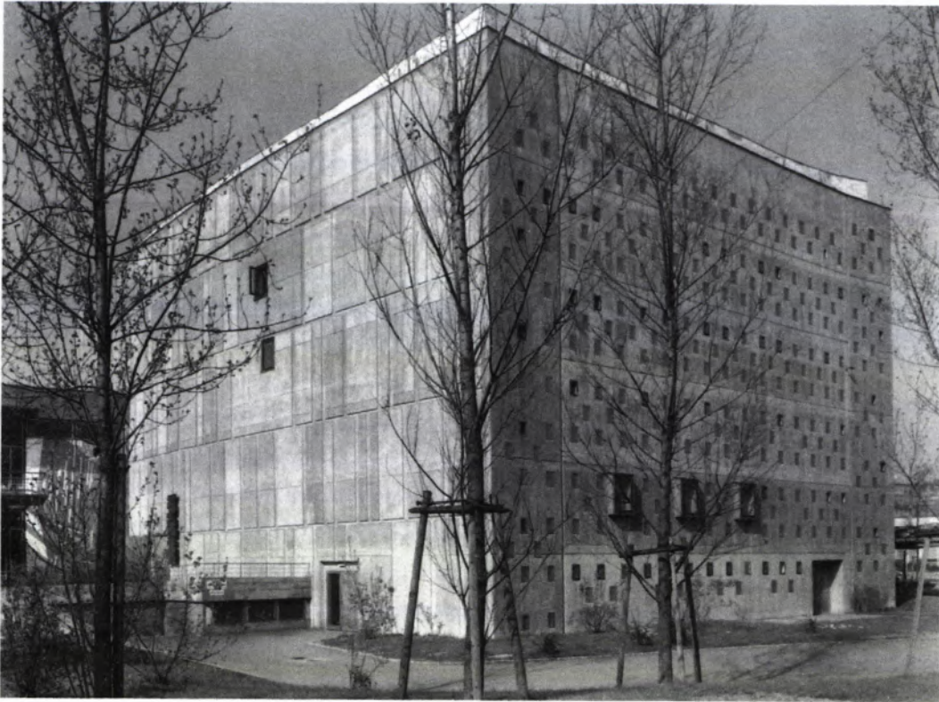
4 BEETHOVENSAAL von Südosten; Gliederung der geschlossenen Sichtbetonwand durch rechteckige Felder in fünf Schichten; Fassade des Bühnenhauses mit zahlreichen kleinen, versetzt angeordneten Lichtöffnungen.
