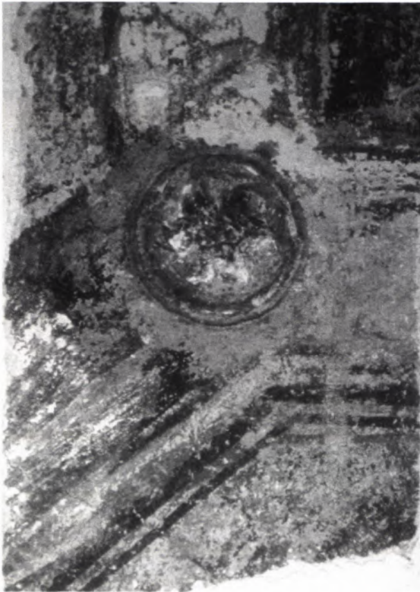
11 NECKARBISCHOFSSHEIM, Hauptstr. 30. Detail aus der Stube im ersten Obergeschoß mit bemaltem rundem Stuckelement im Kreuzungspunkt eines verschiedenfarbig gemalten regelmäßigen Feldersystems, wie es in Abb. 12 rekonstruiert ist.
